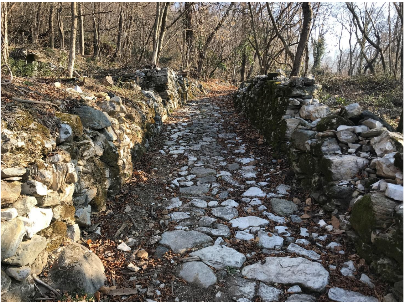
Figura 1. Vestigia dell'utilizzazione agricola della superficie di Piangiovine: mulattiera acciottolata e terrazzi sostenuti da muri a secco.
