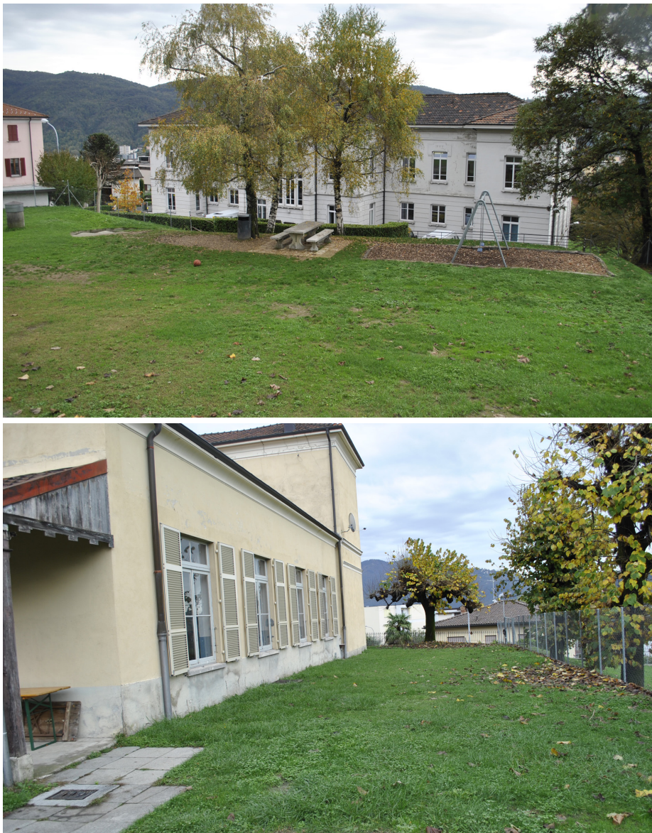
Figura 12 Fotografie dei mappali N. 564 e 98 – ubicazione B “scuole”
