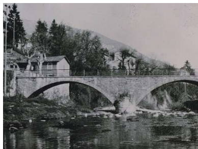
Il vecchio ponte del Picio Archivio Centro sociale
