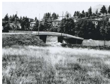
Cavalcavia di Vacallo con sistemazione scarpate terminate – 1964 Archivio Strade nazionali - 1964
